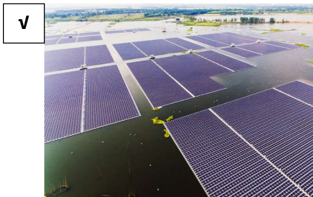
7.2 Foto: Ladang solar atas badan air adalah dibenarkan
