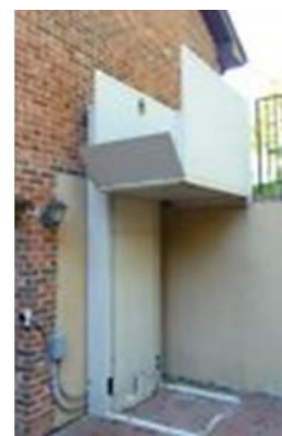
Kemudahan 'handicap lift' patut digalakkan bagi kemudahan OKU di samping penyediaan landas konvensional.
