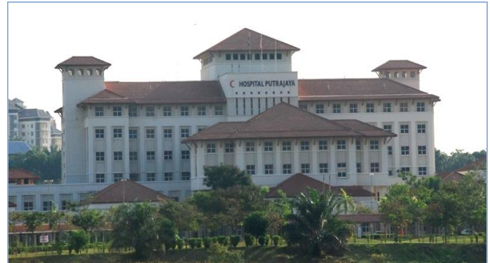
Hospital Putrajaya, Putrajaya. Julai, 2011
