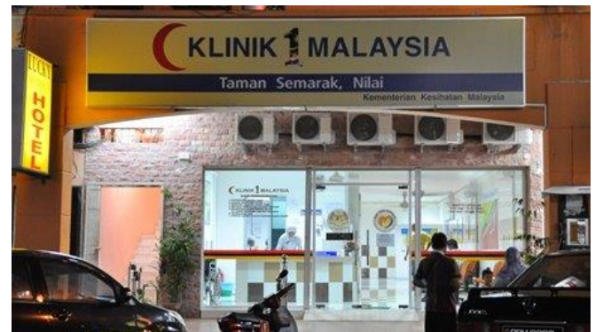
Foto 3: Klinik 1Malaysia di Lokasi Tumpuan Orang Ramai Seperti di Rumah-Rumah Kedai
