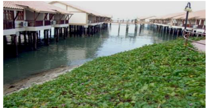
Foto 13: Kajian perubahan hidrodinamik dan morfologi penting bagi memastikan kelancaran arus air dan hakisan pantai yang minimum
