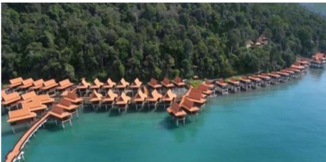
Foto 5: Pembangunan chalet atas air di persisiran pantai (Berjaya Langkawi Resort, Pulau Langkawi, Kedah)
