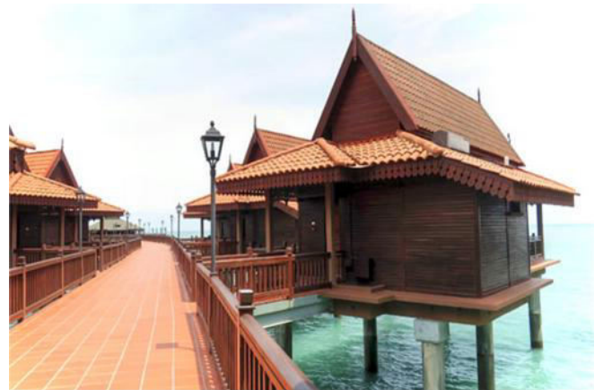
Foto 18: Penyediaan railing dapat menjamin keselamatan pengguna di sepanjang laluan pejalan kaki ( boardwalk )
