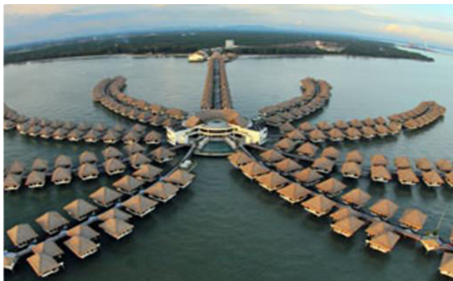
Foto 10: Lokasi pembangunan chalet atas air hendaklah mudah diakses oleh semua pengunjung
