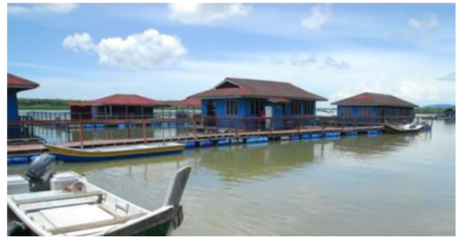
Foto 8: Pembangunan chalet atas air di sungai yang dibina di atas tong dram kosong (Teluk Bayu Floating Chalet, Sungai Merbok, Kedah)
