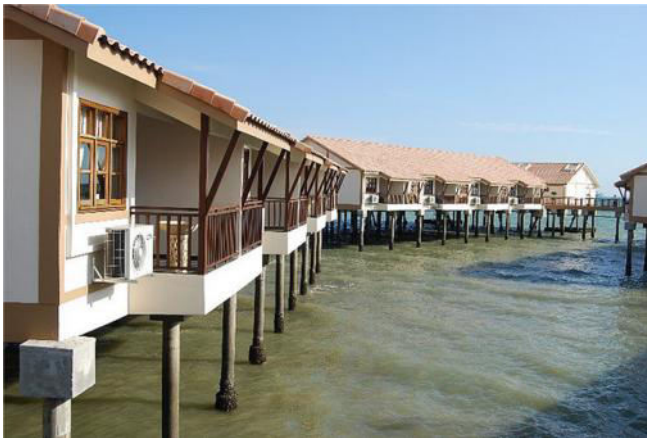
Foto 7: Pembangunan chalet atas air di persisiran pantai yang dibina di atas tiang ( stilt ) (Hotel Grand Lexis, Port Dickson, Negeri Sembilan)
