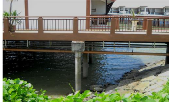
Foto 17: Sistem bekalan air dan pementungan yang dihubungkan dari kawasan daratan
