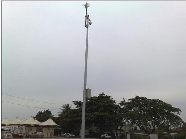
Foto 7: Perletakan CCTV di kawasan Perdagangan – Kuala Terengganu (Julai 2011)
