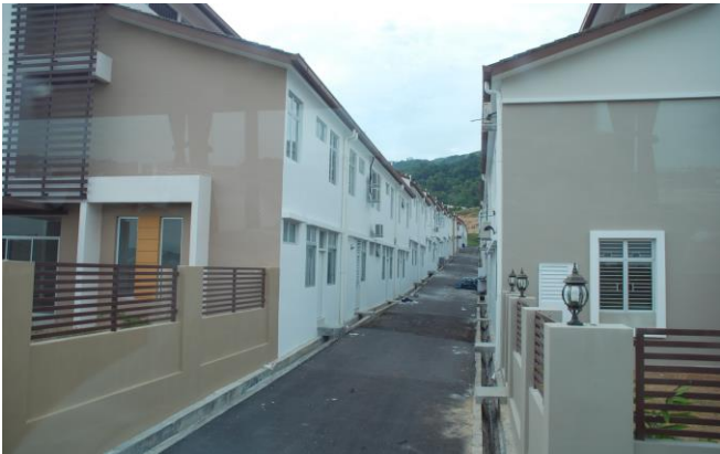
Foto 13: Contoh lorong belakang tanpa anjakan bangunan.
