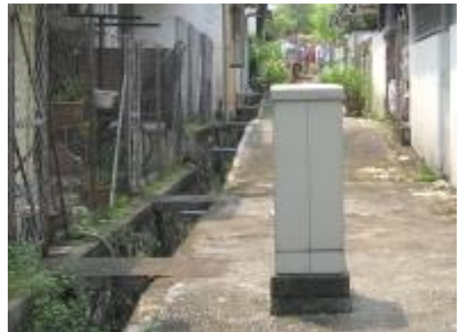
Foto 1: Contoh lorong belakang yang digunakan untuk perletakan infrastruktur.
