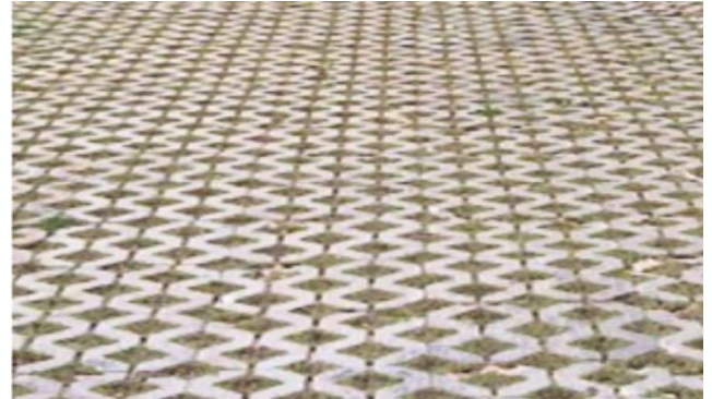
Foto 10: Contoh turapan lorong belakang yang bersifat penyusupan.
