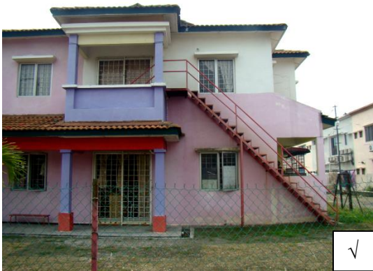
Contoh Tadika di lot kediaman yang menyediakan tangga kecemasan (Bandar Baru Bangi, 14 Julai 2011).
