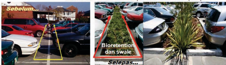
Bioretention di sepanjang sisi jalan
