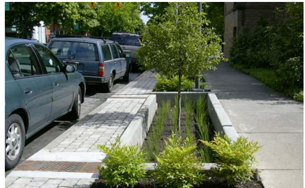
Foto 16 : Penggunaan tree box filters untuk mengurus air hujan ditepi jalan
