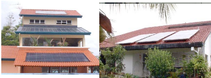
Foto 22: Contoh penyediaan ruang bagi menempatkan panel solar di atas bumbung yang dilaksanakan di Malaysia
